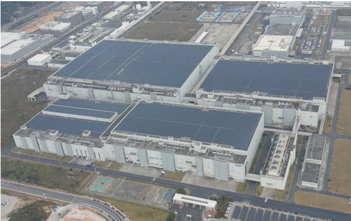
超视界光伏发电项目
